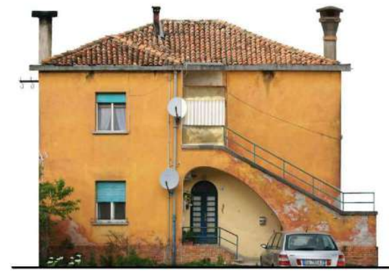
fotoprospetto sud photo-elevation south
