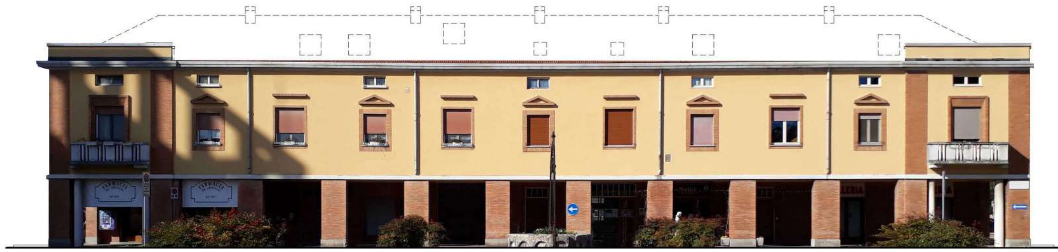
fotoprospetto sud photo-elevation south
